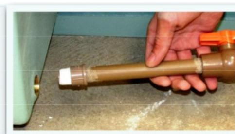
Caso o climatizador seja instalado em local onde o registro de água de alimentação fique em difícil acesso é muito importante que a tubulação de alimentação seja levada a um local de fácil acesso aonde possam ser instaladas, para que a operação de alimentação e drenagem possa ser facilmente executada
